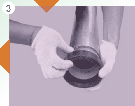
第三步. 將密封圈套入喉端
