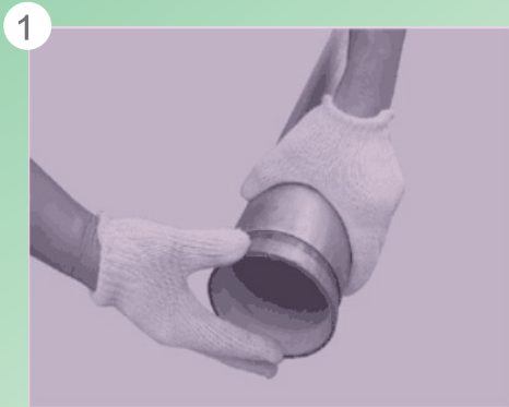
第一步. 檢查喉管端部毛刺
